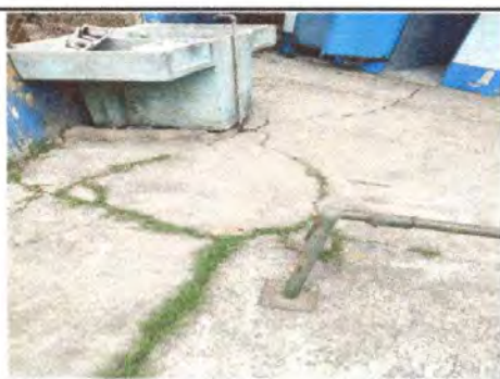
Foto 5: Reparación de planchas de concreto de patio
