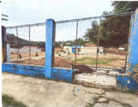
Foto 1: Reparación de muro perimetral de block con tubo hg y malla galvanizada, soleras intermedias y columnas.
