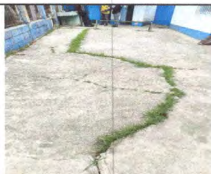
Foto 6: Reparación de planchas de concreto de patio
