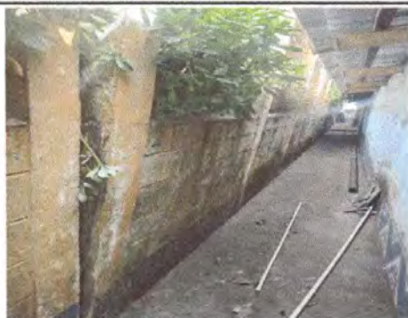
Foto 3: Reparación de muro perimetral de block con tubo hg y malla galvanizada, soleras intermedias y columnas.
