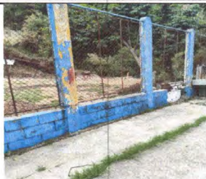
Foto 2: Reparación de muro perimetral de block con tubo hg y malla galvanizada, soleras intermedias y columnas.
